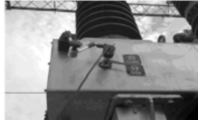
35KV SF6 开关传感器安装
